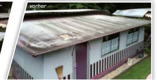
Unproblematisch und passgenau: Komplette Erneuerung vor Ort
